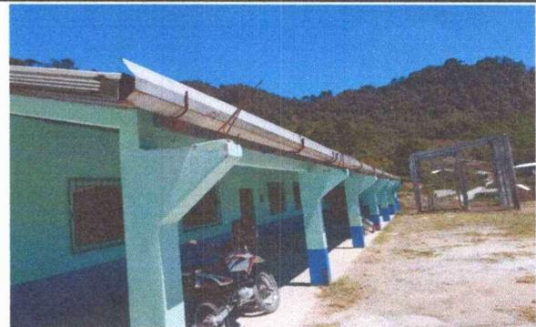
Foto 4: Canales y bajas de agua pluvial
